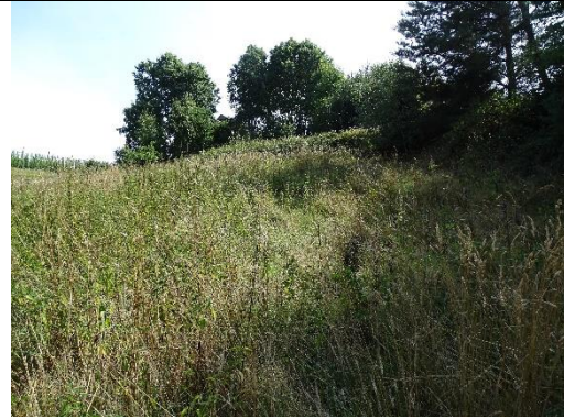
23_6_20 Wiese und Böschung.JPG
